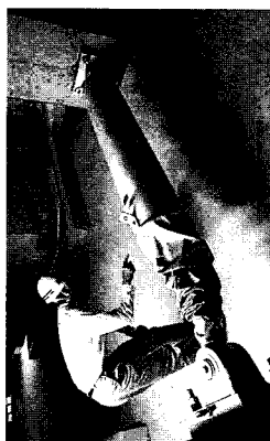
大阪府庁本館で使われているKYB製の免震オイルダンパー
