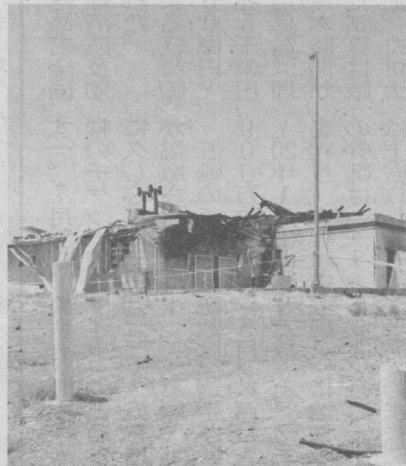
イランが公開した火災でダメージを受けた核施設（2日、ナタンツ）＝ロイター
